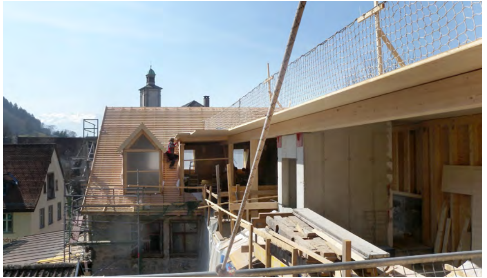
Gute Fortschritte bei den Umbau- und Sanierungsarbeiten beim Projekt Neustadt 14
